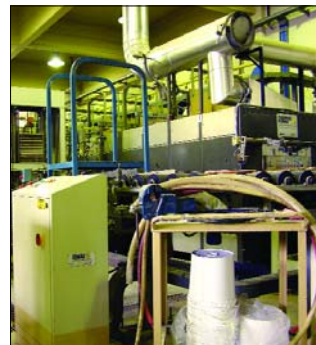
Planta Piloto - Horno a rodillos para desarrollos cerámicos y control de calidad de producto terminado
