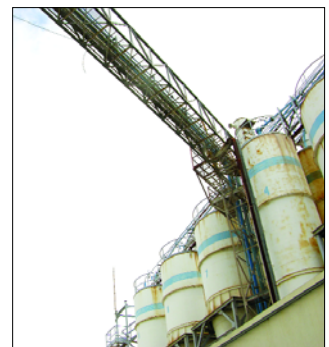
Silos de materia prima y cañerías de transporte neumático de mezclas hacia los hornos
