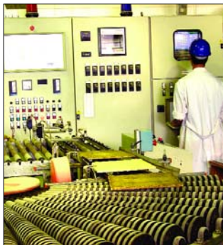
Planta Piloto - Panel de comando del horno a rodillos
