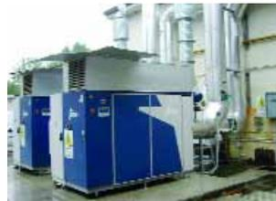
Se reporta el caso de los hornos industriales Unieco Fosdondo (Provincia de Reggio Emilia, Italia) que en el 2004 instaló dos microturbinas Turbec T100P (Fig. 2), de 100 kW de potencia eléctrica, suministrada por un proveedor de electricidad.
