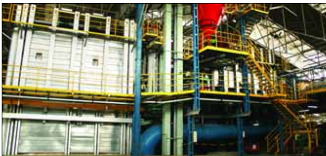
Panorámica del horno 1, muy similar a la que tendrá el horno 7
