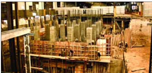
Construcción de estructura de hormigón armado; sostén del nuevo horno 7.
